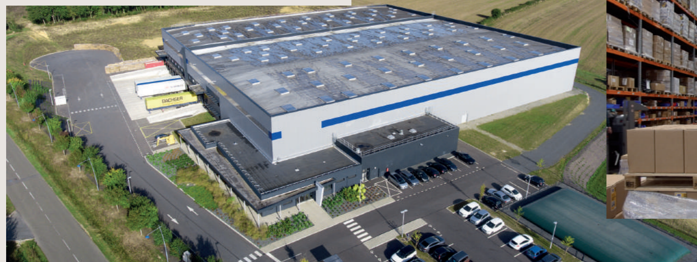
Opérationnel en janvier 2020, Gys II, le centre logistique de Changé, situé au nord de Laval, s'étend sur 10 000 m 2 , dont 1 000 m 2 de locaux sociaux. En 2023, l'entrepôt gagnera 10 000 m 2 de surface supplémentaires.
